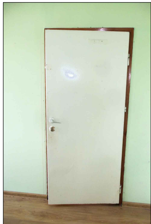
FOTOGRAFIA DRZWI PRZEZNACZONE DO DEMONTAŻU (widok z pomieszczenia 1.15)
