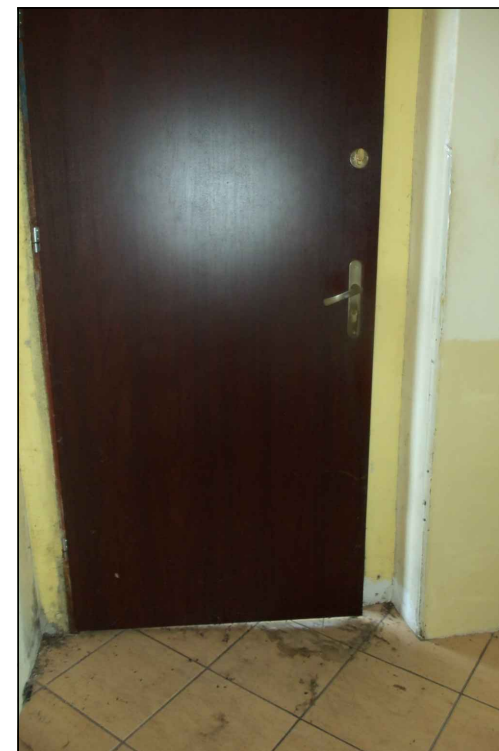
FOTOGRAFIA DRZWI PRZEZNACZONE DO DEMONTAŻU (drzwi wejściowe)
